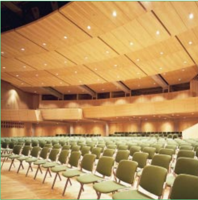
In repräsentativen Gebäuden sind Wand- und Deckenverkleidungen aus Esche besonders eindrucksvoll
